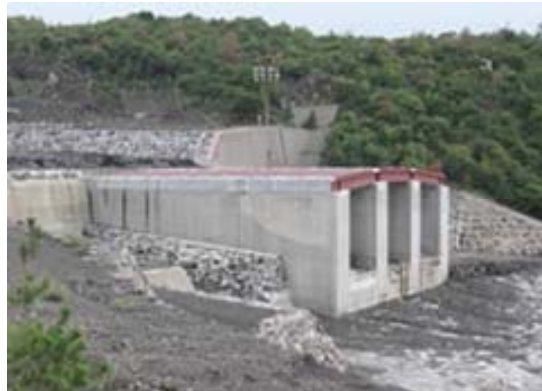
写真-1.4 底面水抜きスクリーン
