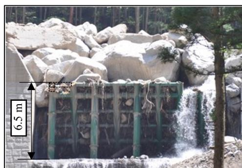
写真-3.2 梨子沢第2砂防堰堤
