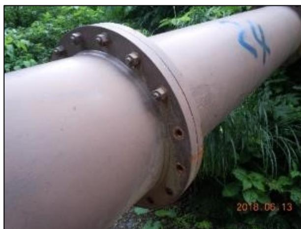
(b) 曲げ破断継手
