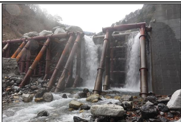
写真-1.6 損傷した朴の木堰堤
