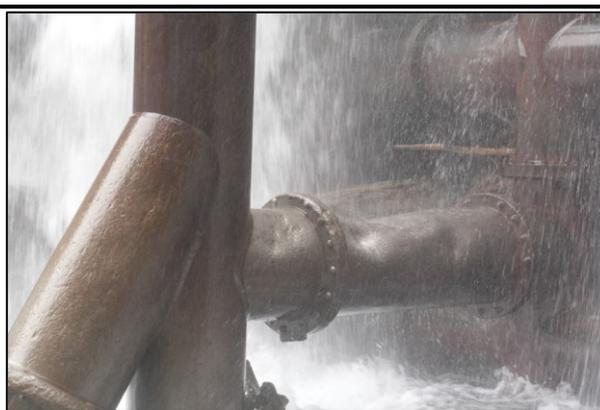
写真-1.7 朴の木堰堤の下部水平材
