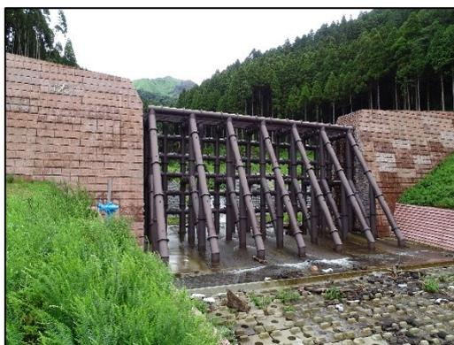
写真-1.1 鋼製透過型砂防堰堤
